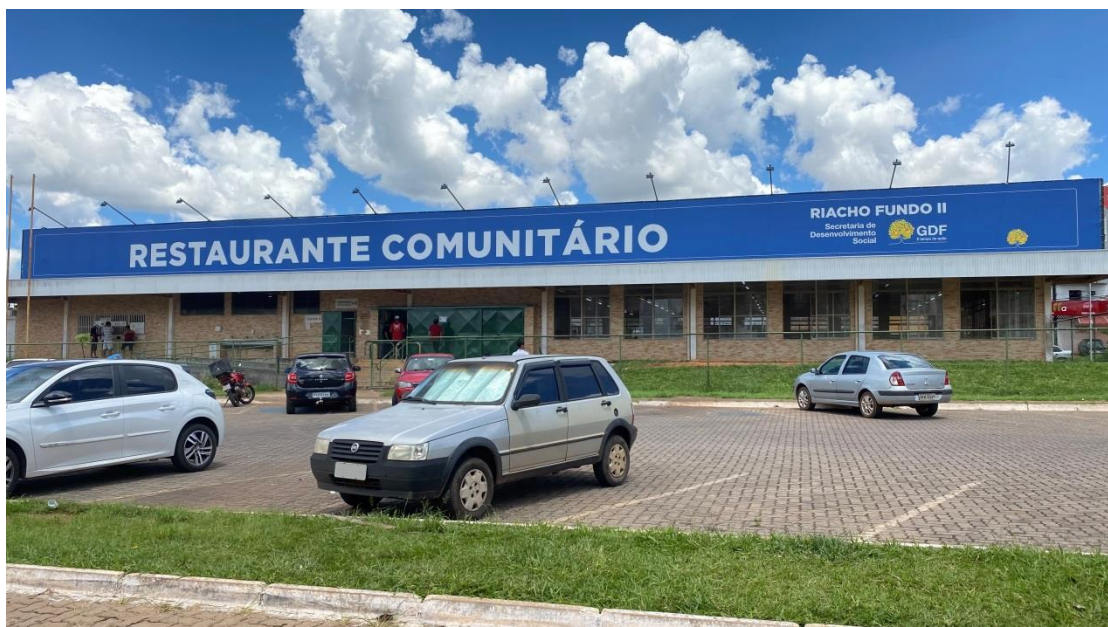
Figura 1 - Fachada do Restaurante Comunitário do Riacho Fundo II
