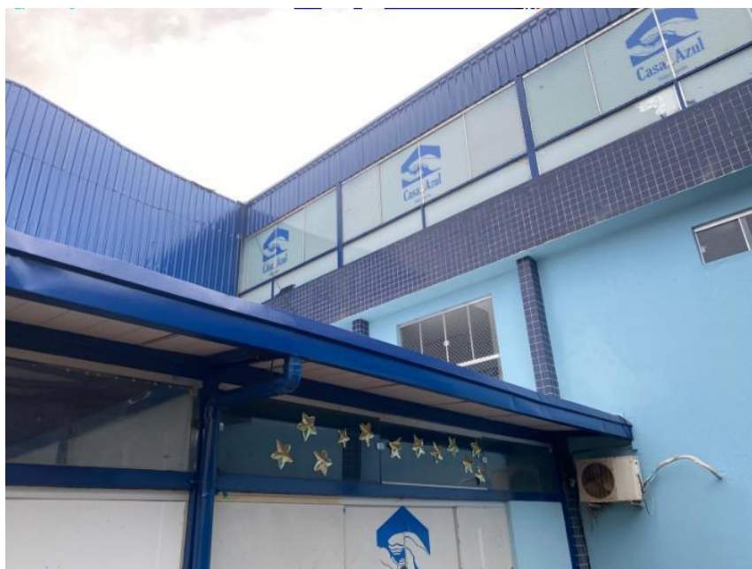
Figura 6: Estrutura física e fachada da instituição Casa Azul.
